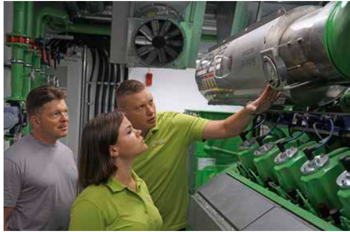
Achim Reber, Isabell Tucheck und Markus Wiench arbeiten eng zusammen – hier bei der Prüfung eines Luftfilters.
